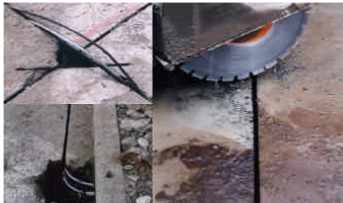
Fig1 – Fresatura del terreno per l'inserimento dei cavi.
