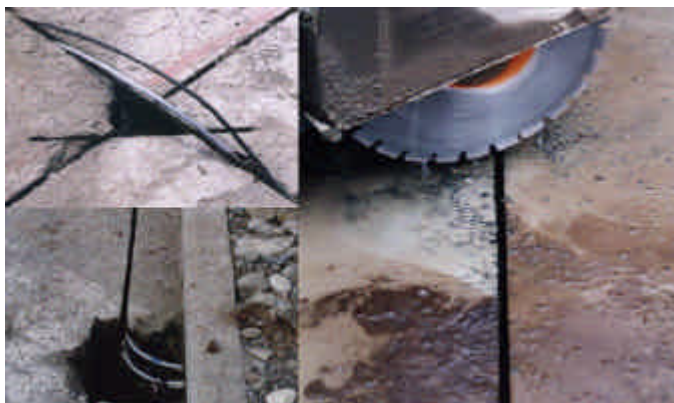
Fig1 – Fresatura del terreno per l'inserimento dei cavi.
